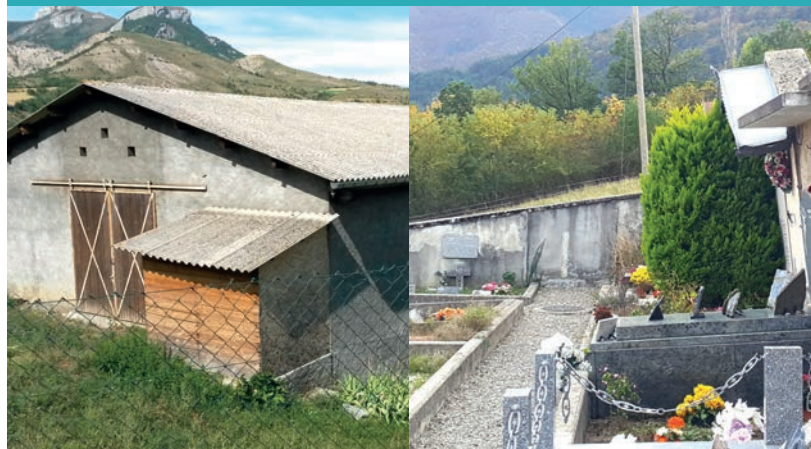
À Barillonnette, la réfection du toit de la bergerie et d'un mur du cimetière va bénéficier du fonds de concours de la Communauté d'agglomération.
