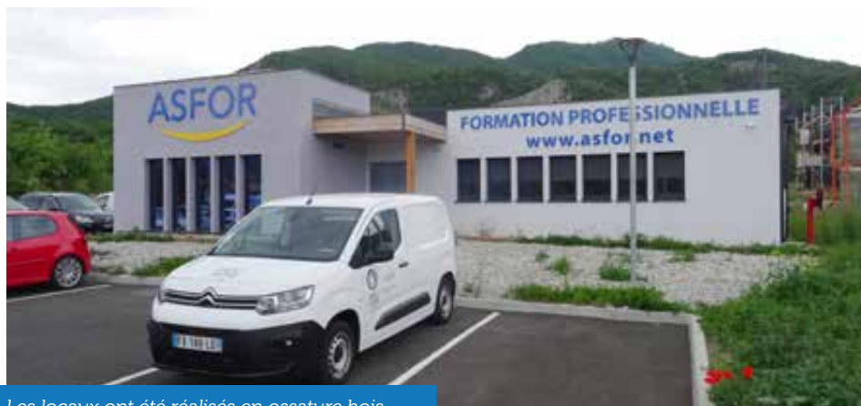
Les locaux ont été réalisés en ossature bois.
