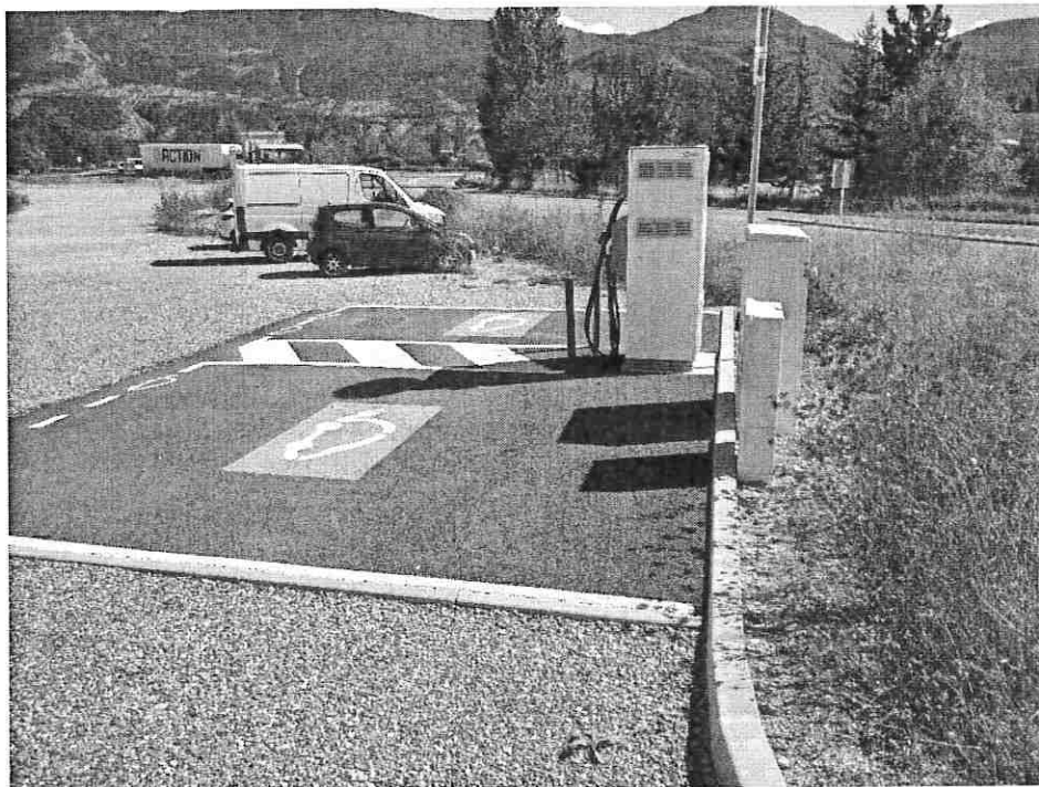
Figure 3. Borne de recharge électrique existante
